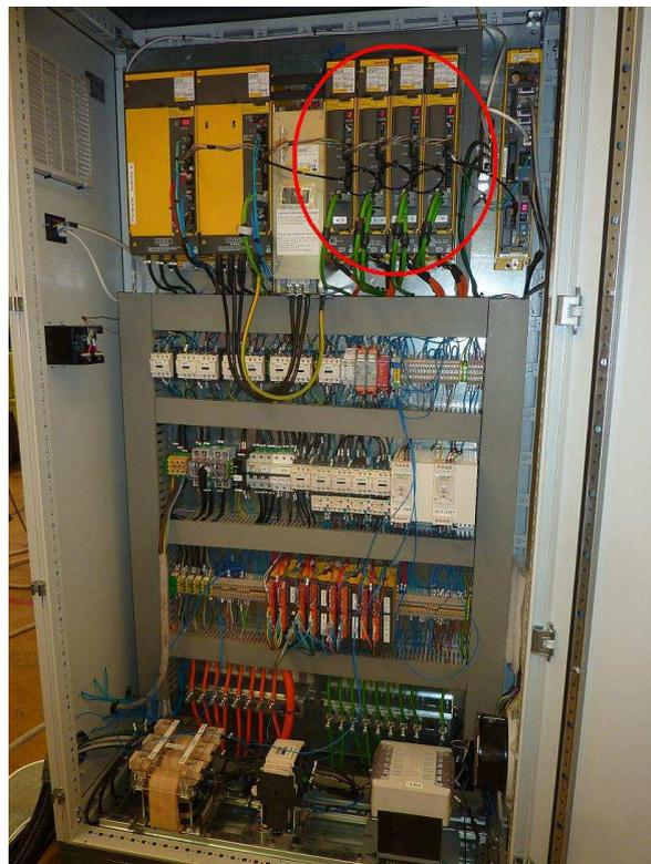
Nella parte alta di ogni singolo azionamento, leggere l'etichetta Fanuc per individuare il modello dell'azionamento.
